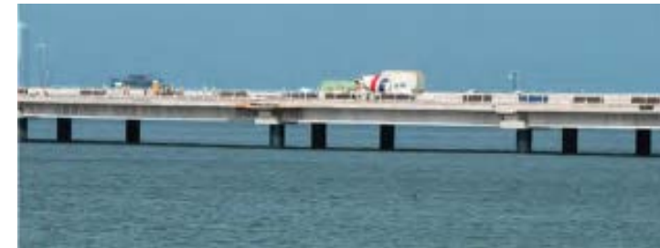
Vigas Longitudinales, Cinta Costera, Fase III, Panamá 2014.
