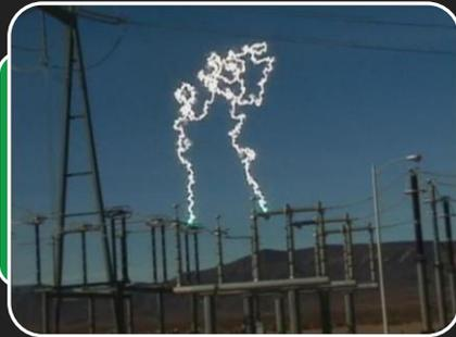
Interrupción súbita de un circuito bajo carga mediante un interruptor.
