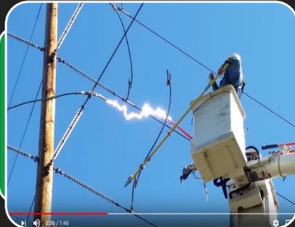
Interrupción súbita de un circuito bajo carga por acción u omisión.
