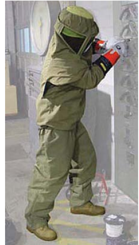
Protección HRC 4 según NFPA 70E . 44 cal/cm 2
