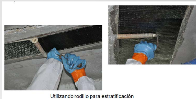
Utilizando rodillo para estratificación
