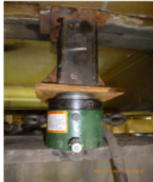
Colocación de gato para la elevación de la viga.
