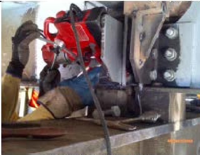
Barrenado en viga larguero.
