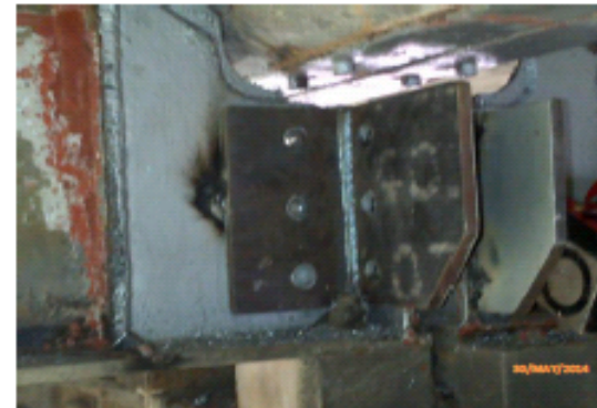
Colocación de pieza para toma de medida de plantilla.
