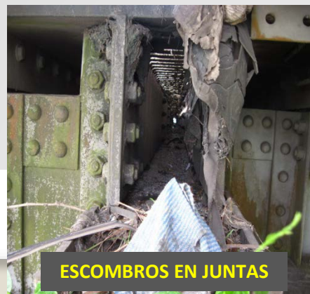
CORROSION SEVERA – PERDIDA DE SECCION
