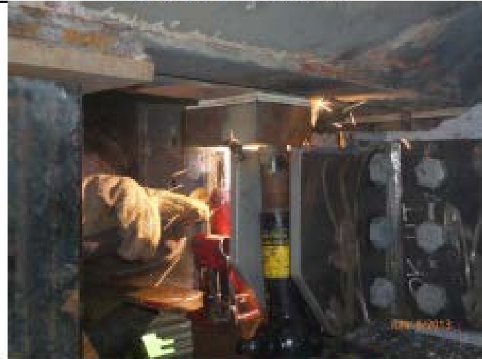
Soldadura de bloque de acero
