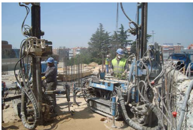
Figura 3: Ejecución de trabajos de micropilotes
