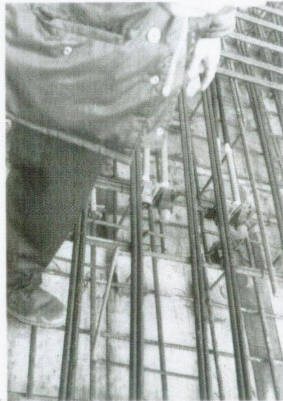
*Anclajes pasivos embebidos en el hormigón.*
