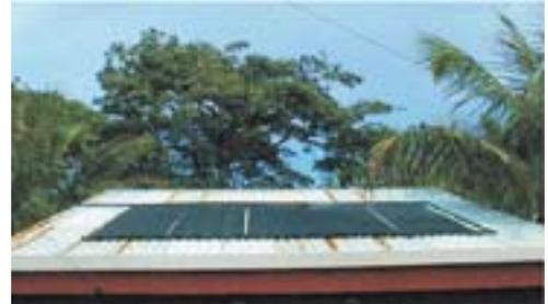
Figura 3. Colectores solares para calentamiento de piscinas.
